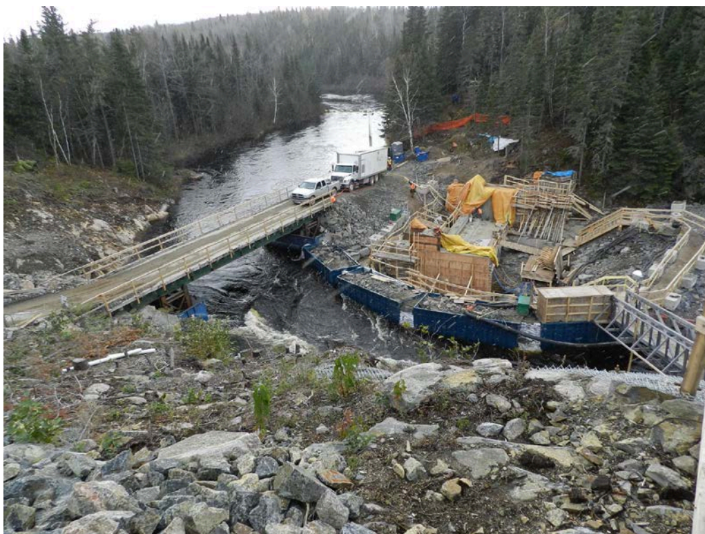
Bétonnage pour construire la digue de dérivation à 1 km en amont.
