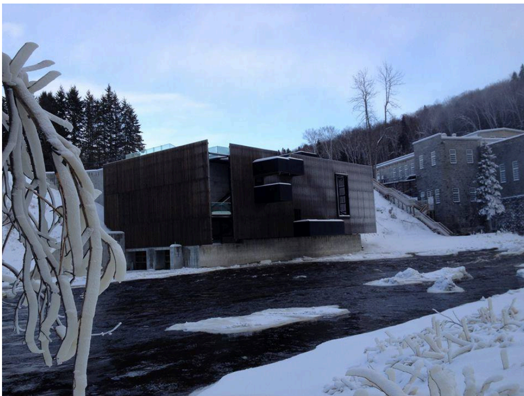
Le nouveau bâtiment « d'allure très contemporaine » au 24 février 2015.
